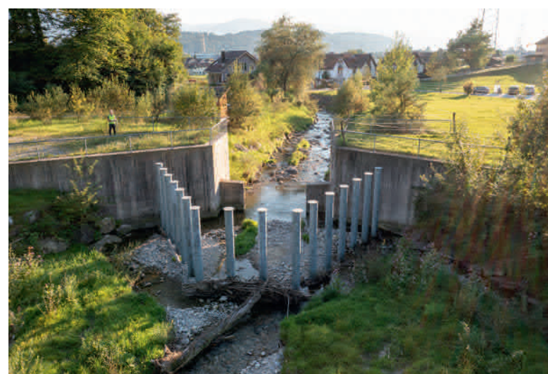
Abbildung 9: Geschiebeablagerungsplatz Ernetschwilerbach in Uznach: Verengungsbauwerk mit Pfahlrechen. | Figure 9 : Emplacement de dépôt des sédiments Ernetschwilerbach à Uznach : ouvrage de rétrécissement avec râteau à pieux.
