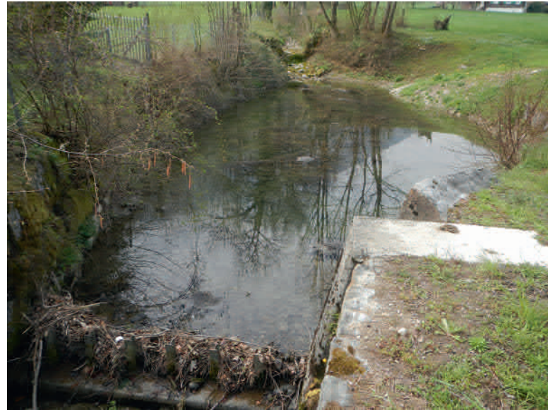
Abbildung 3: unterer Geschiebeablagerungsplatz am Dürrbach. | Figure 3 : Emplacement de dépôt des sédiments en aval sur le Dürrbach.
