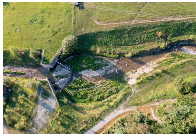
Abbildung 8: Geschiebeablagerungsplatz Ernetschwilerbach in Uznach aus Drohnensicht. | Figure 8 : Emplacement de dépôt des sédiments Ernetschwilerbach à Uznach, vue par un drone.
