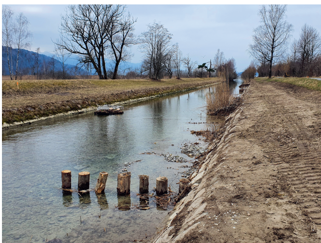
Abbildung 7: Situation unmittelbar nach dem Einbau der Struktureinbauten und vor der Uferbepflanzung.
