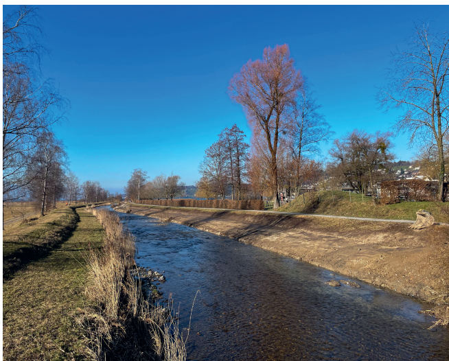
Abbildung 6: Reprofiliertes Gerinne, vor dem Einbau der Strukturmaßnahmen und vor der Uferbepflanzung, Blick in Fließrichtung.
